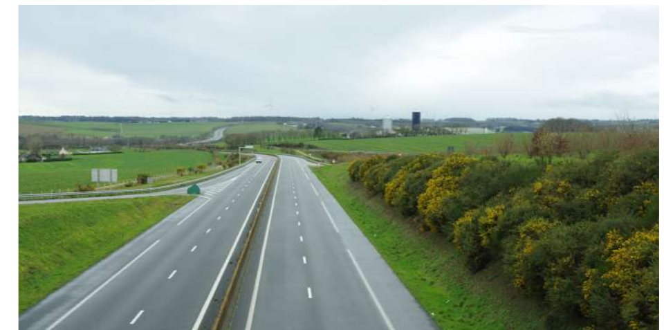
La N164 et ses talus limitant les vues depuis les franges de Loudéac
