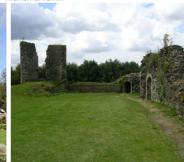
Château à Corlay (n°53) - Source : https://monumentum.fr
